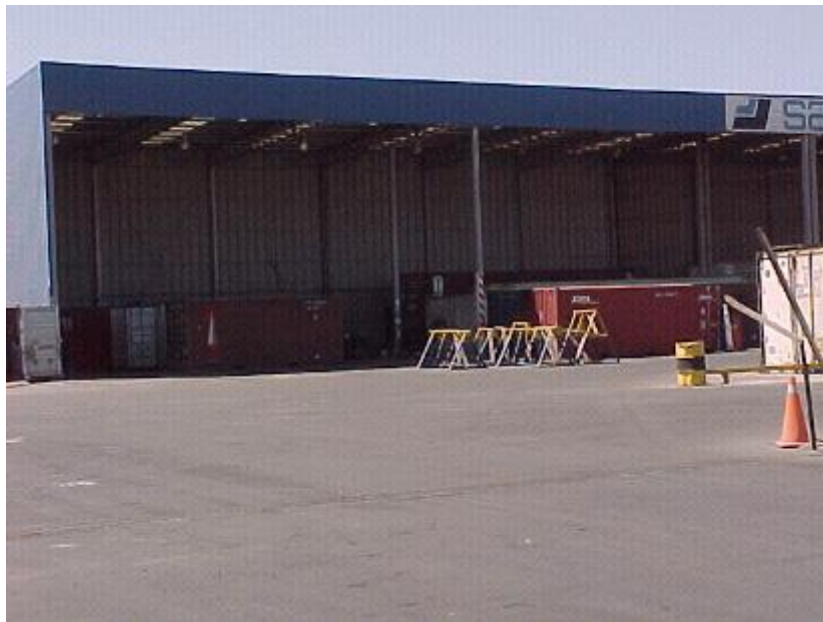
Zona de Reparaciones de Estructura
